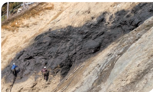
奈良県 復旧治山事業
