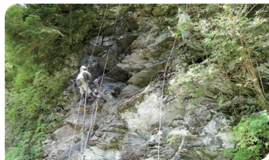
奈良県 林業専用道
