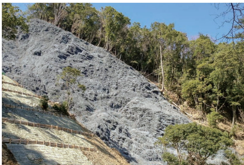
特殊配合モルタル吹付工
