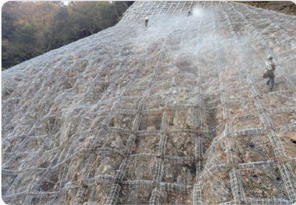
静岡県榛原郡 グリッドフレーム 150
