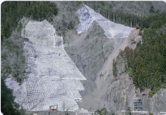
静岡県榛原郡 グリッドフレーム 200
