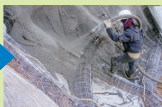
7 枠吹付け状況
