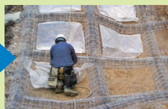
6 枠シート設置工
