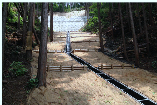
種子無し施工現場写真
